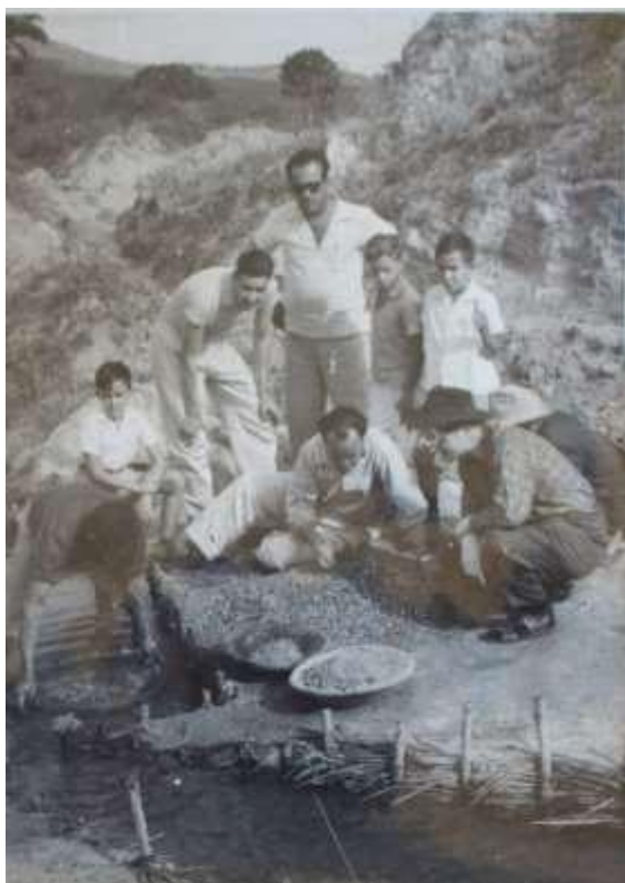
Figura 10: Homens verificando a presença de diamantes no cascalho. Na parte de baixo vê-se um rego, canal escavado pelos garimpeiros para desviar a água dos rios e nascentes da serra para facilitar a lavagem do cascalho – autor desconhecido, s/d. Fonte: acervo de Mestre Osvaldo
