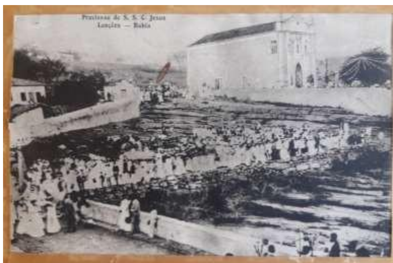
Figura 80 - Fotografia da Procissão de S. S. C. Jesus chegando na Igreja de Nosso Bom Senhor dos Passos. Na imagem podemos perceber com mais clareza o lajedo em que a edificação se situa. Acervo do Escritório técnico do IPHAN em Lençóis. Foto: Raul Lanari
