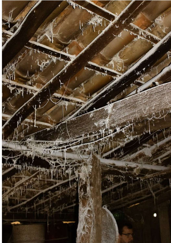
Foto 60 – Interior do Engenho do Quinca. Créditos: Acervo dos autores.
