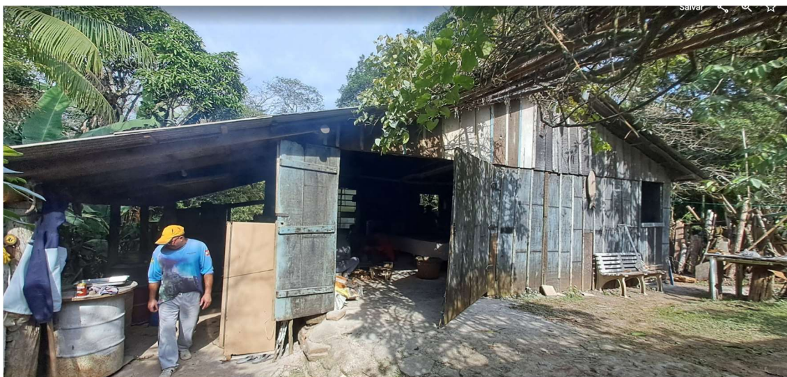
Foto 66 – Alpendre do Engenho do Neca. Fonte: Acervo dos autores.
