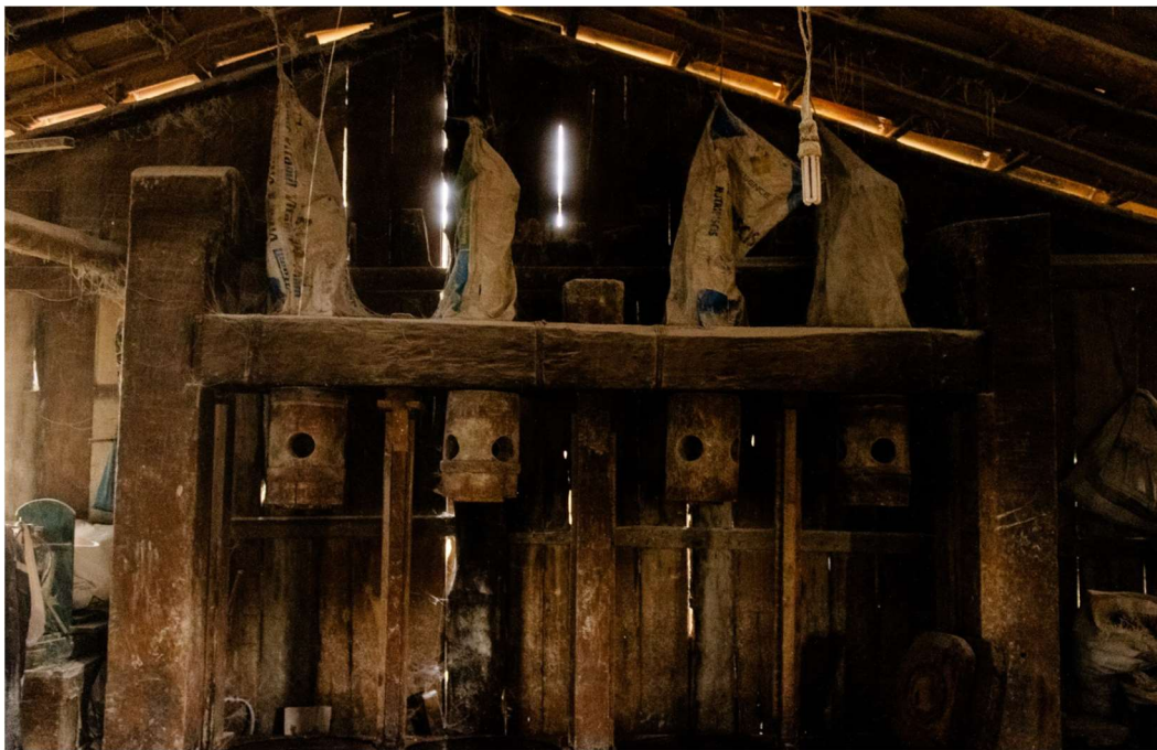
Foto 62 – Interior do Engenho do Quinca. Créditos: Acervo dos autores.
