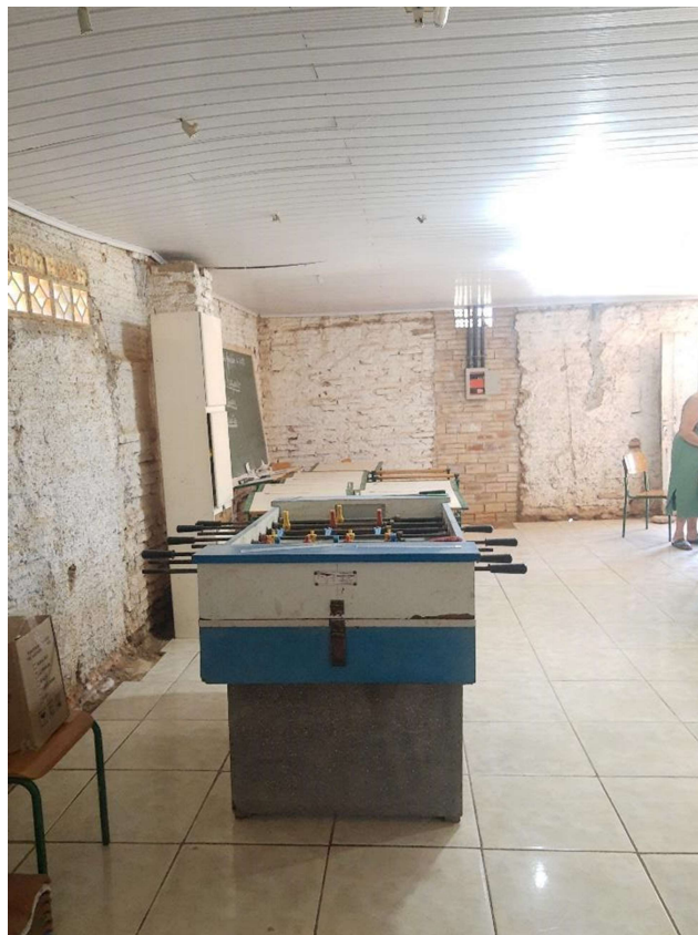
Foto 33: Vista interna do antigo engenho (sala de aula). Créditos: Lilian Fabre.
