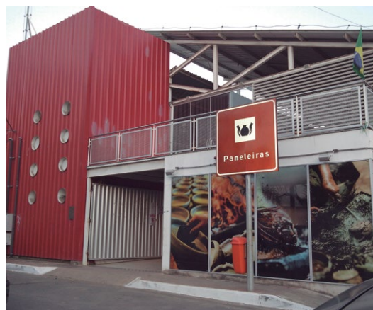
GALPÃO DAS PANELEIRAS. GOIABEIRAS VELHA, VITÓRIA-ES. FOTO: EVANDRO ROSA, 2015.
